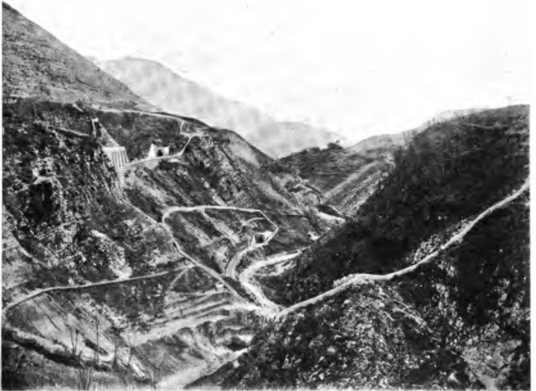
VEDUTA DELLA VALLE DEL LIRI DA CAPISTRELLO.
